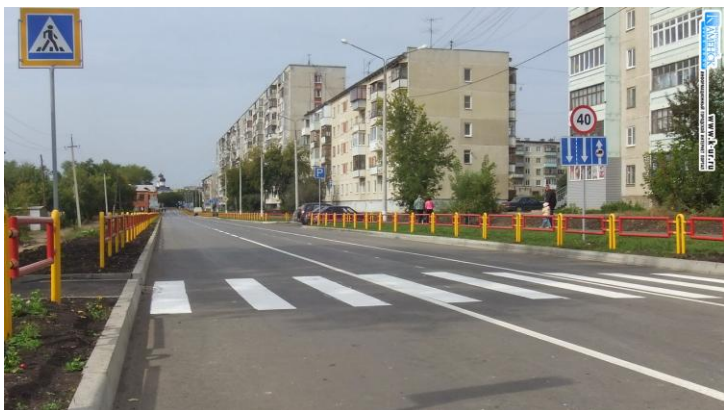
Фото 10. Новая автодорога по улице Кирова, построенная в рамках целевой программы «Развитие транспортного комплекса Свердловской области»
